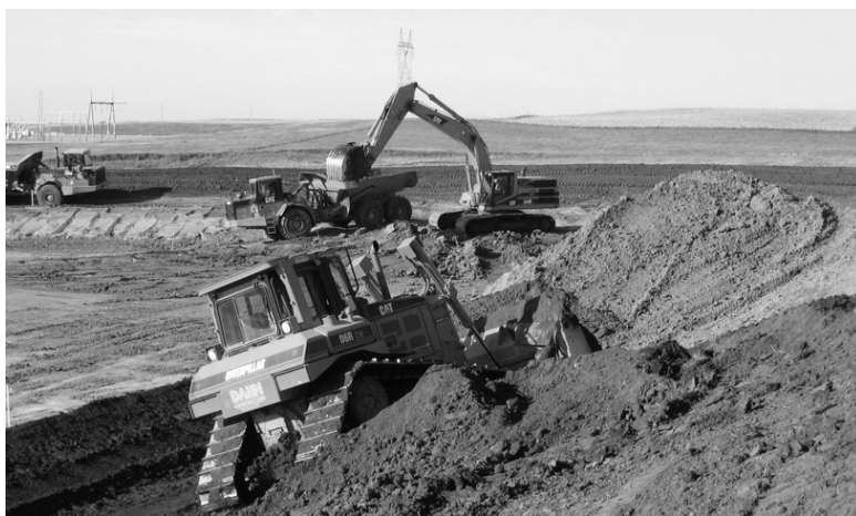
Рис. 1. Проведение земельных работ, связанных с переносом больших объемов грунта и снятием верхнего почвенного слоя
